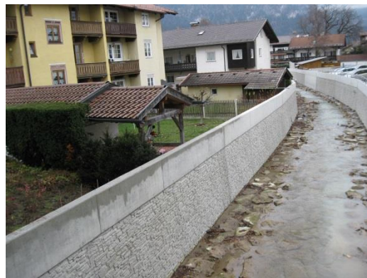
Abbildung 3: Hochwasserschutz abgeschlossene Maßnahme Die gewässer-nahe Bebauung ließ die Kosten explodieren. Nur mit extrem aufwendigen Sonderverfahren und Beweissicherungsprogrammen war überhaupt eine Lösung zu finden. Doch die Probleme sind mit dem Bau nicht vorbei, spätestens bei der turnusmäßig durchzuführenden Unterhaltung tauchen sie wieder auf. Ebenso ist im Hochwasserfall eine Zugänglichkeit für Einsatzkräfte nicht gegeben.
