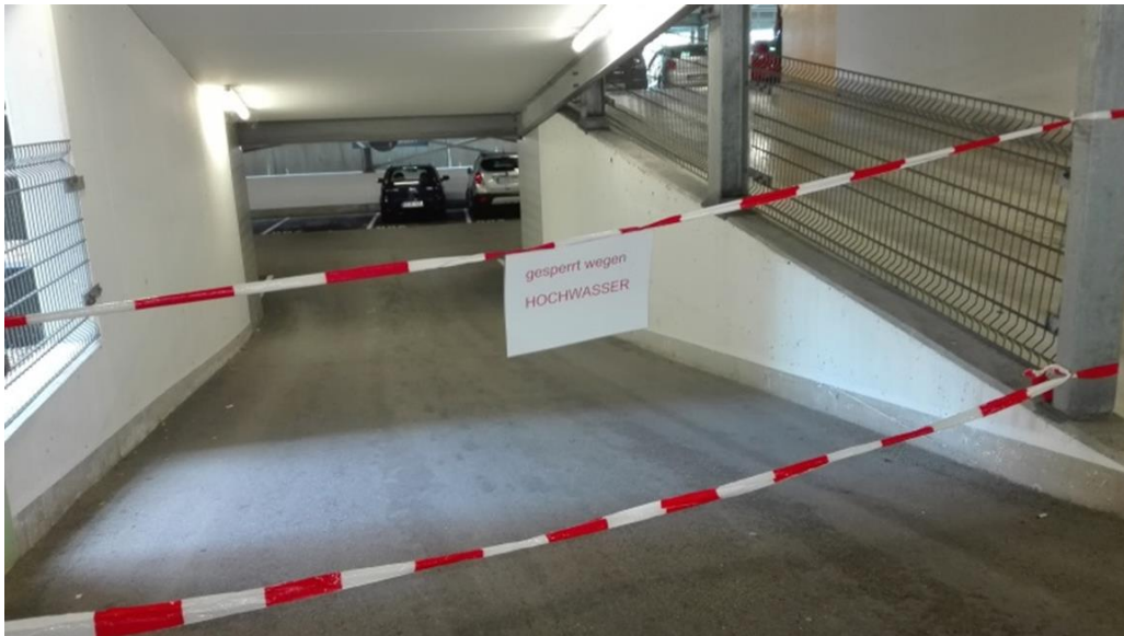
Abbildung 1: Beispiel einer organisatorischen Maßnahme - Gemäß Alarm- und Einsatzplan wird die Zufahrt ins Tiefgeschoss des Parkhauses bereits bei drohenden Starkregenereignissen als Vorsorgemaßnahme gesperrt.
