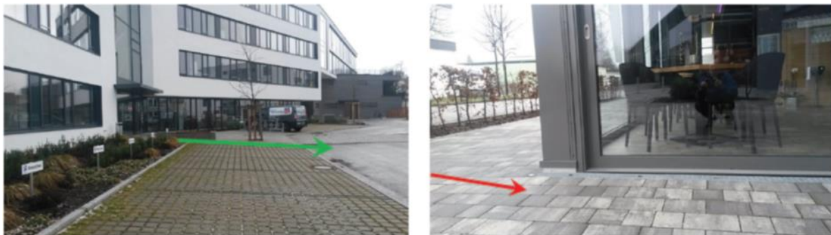
Abbildung 5: Das umliegende Gelände sollte so gestaltet werden, dass Niederschlagswasser vom Gebäude wegfließen kann (links). Ein Gebäude, dessen Erdgeschoss unter dem Straßenniveau liegt, ist bei Starkregen besonders gefährdet. (Fotos: P. Geisenhofer – WWA Rosenheim)
