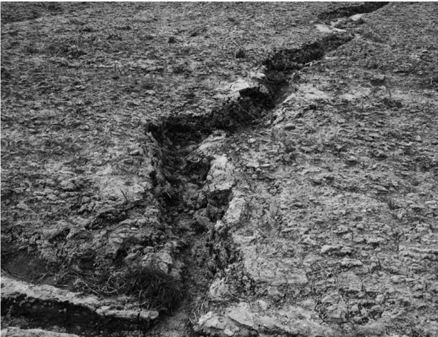
E33 | Grabenerosion durch fließendes Wasser.
